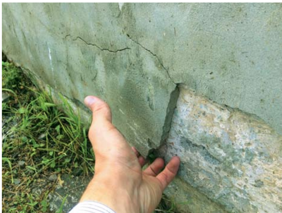
Фото 3. Пример отскока материала с прочностью на сжатие 80 МПа из-за недостаточного качества подготовки материала. Объект в г. Нижний Тагил
