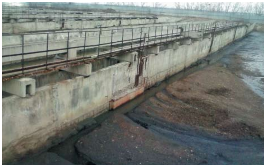
Фото 1. Объект до ремонта
