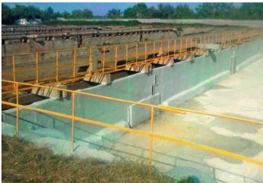
Фото 2. Объект после ремонта
