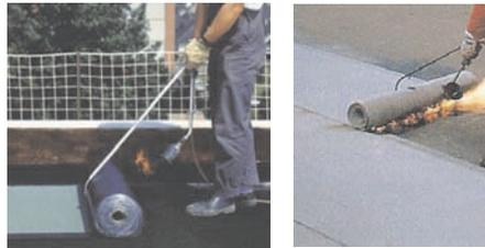
Рисунок 3.11 - Использование захвата-раскатчика при наплавлении
