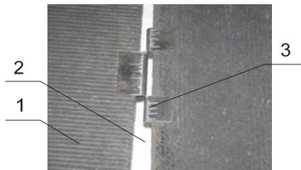
1 – асбестоцементные листы; 2 – теплоизоляционные плиты; 3 – кляммер.
