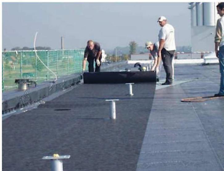
Рисунок Ш6 – Установка электропроводящего слоя
