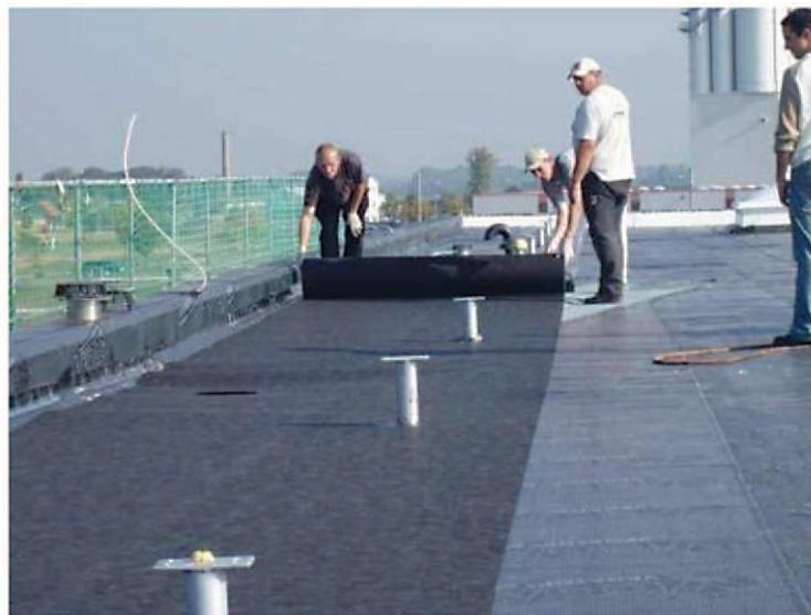
Рисунок Ш6 – Установка электропроводящего слоя
