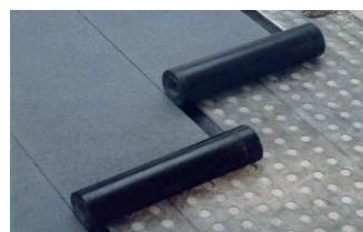
Рисунок 2.11 – Устройство вентилируемой кровли с применение материала KIROOF PERFOR
