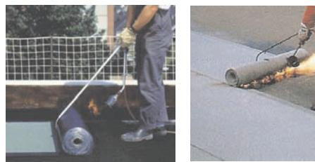
Рисунок 3.11 - Использование захвата-раскатчика при наплавлении
